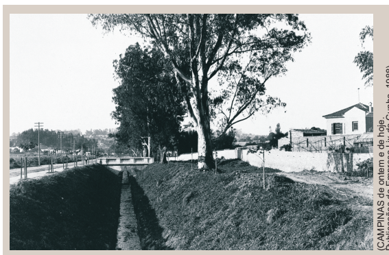
Córrego do Saneamento já canalizado, antes de a Av. Orosimbo Maia ser asfaltada nos dois sentidos.
